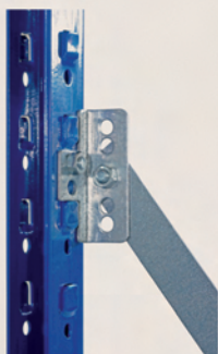
Befestigung Diagonalverband
